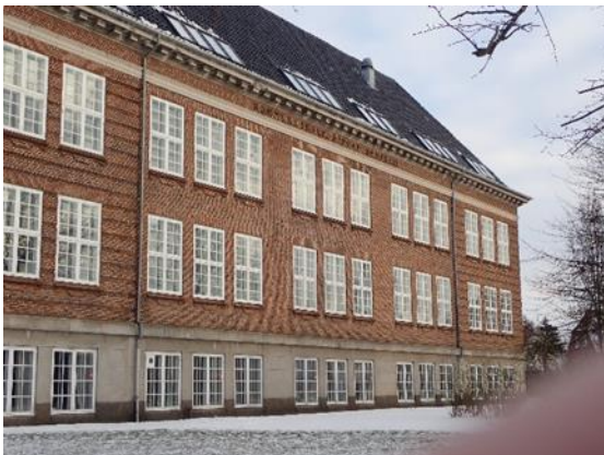
Rudkøbing tidligere skole, hovedbygningen fra 1921
