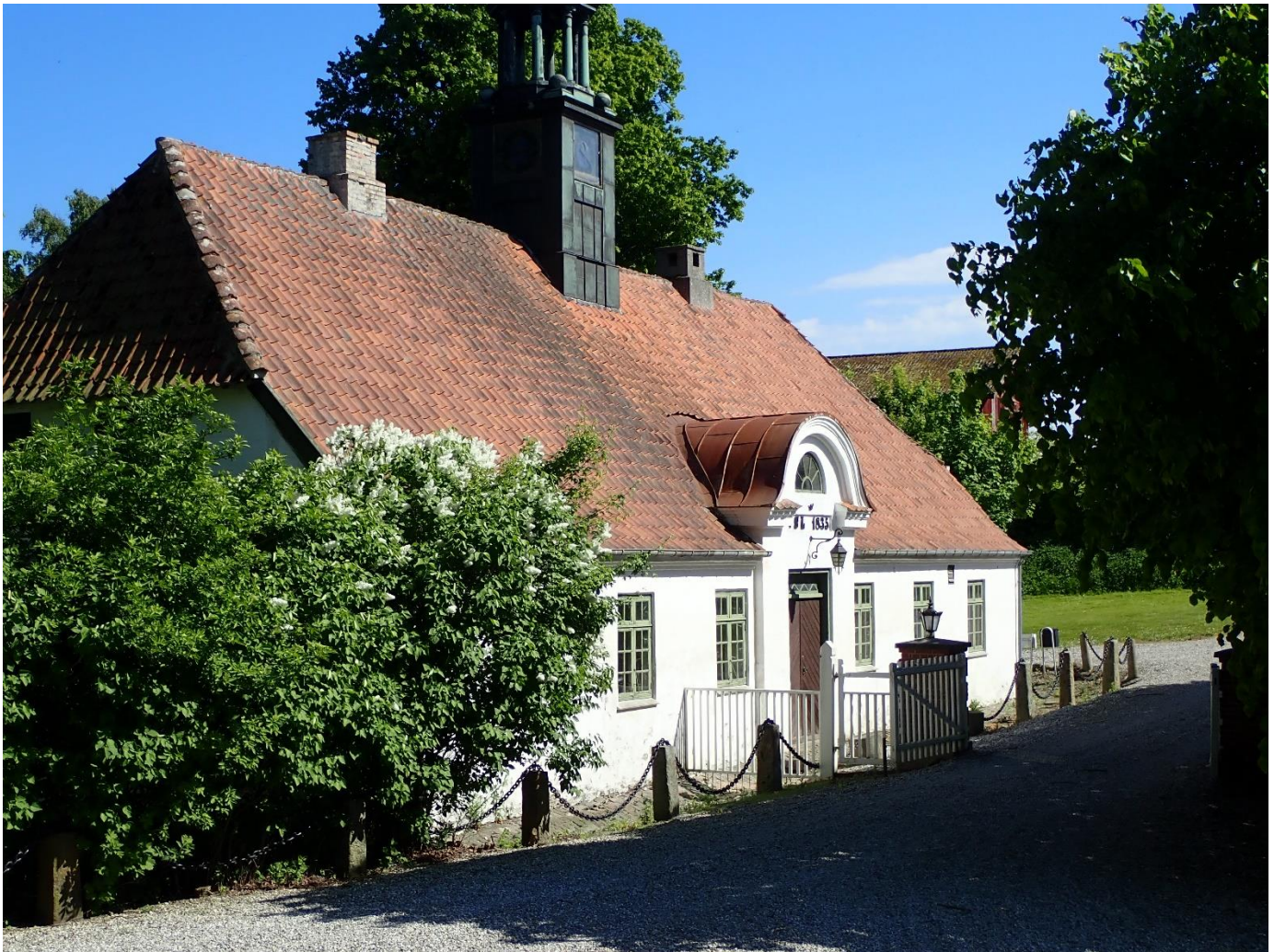
Den fine lille herskabsstald på Steensgård, opført 1835
